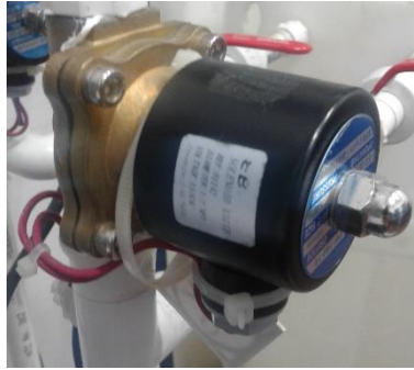
Figura 29 Válvula solenoide EBC-HQ. Fuente: Autor
