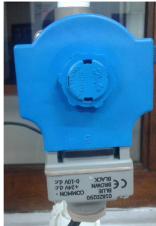
Figura 31 Servoválvula DANFOSS EV260B. Fuente: Autor
