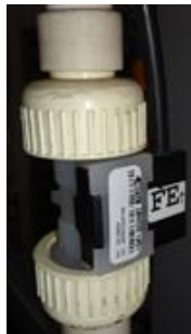
Figura 34 Sensor de caudal SIGNET 2100. Fuente: Autor
