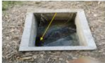
Foto 6. Lugar: Casco urbano municipio de Corinto. Fecha: 4 de marzo de 2020. Observación: Cámara de salida de Laguna Facultativa (punto de toma de muestra).
