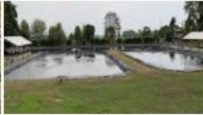
Foto 4. Lugar: Casco urbano municipio de Corinto. Fecha: 4 de marzo de 2020. Observación: Lagunas Anaerobias y Facultativa.
