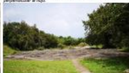
Foto 4. Lugar: Casco urbano municipio de Caloto. Fecha: 2 de marzo de 2020. Observación: Tratamiento primario y secundario seis (6) unidades de Tanques Sépticos + FAPA construidos en concreto.
