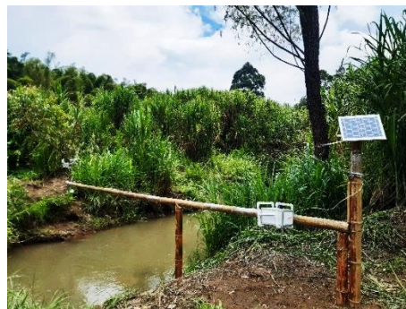
Figura 5.6.38 Implementación de la estación en el punto de monitoreo La Violeta Fuente: Propia
