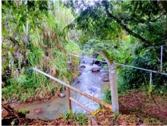
Figura 5.1.6 Instalación de la estación para la prueba de calibración en Campo Real Fuente: Propia
