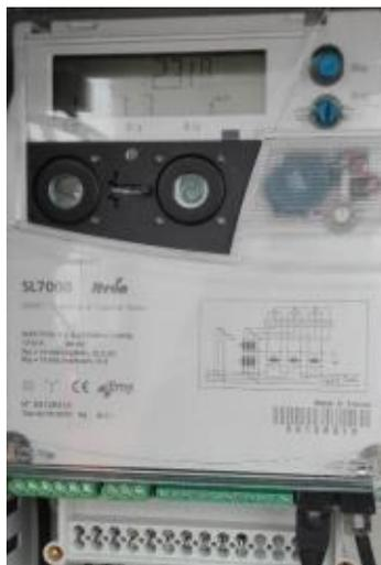
Figura 11 Medidor trifásico ACE ITRON SL-7000 Fuente: Propia
