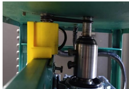
Figura 27. Instalación del Encoder.
