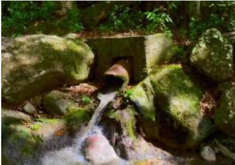
Fig. 4. Vertimiento de las aguas residuales del Hospital San Antonio de Padua.
