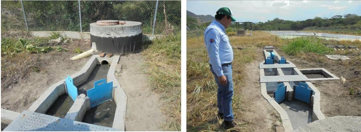
El sistema de tratamiento de las aguas residuales del reasentamiento, se ha construido una caseta con lechos de secado para el manejo de lodos del sistema, cuyo lixiviados son conducidos mediante tubería hacia la laguna facultativa (ilustración 23).
