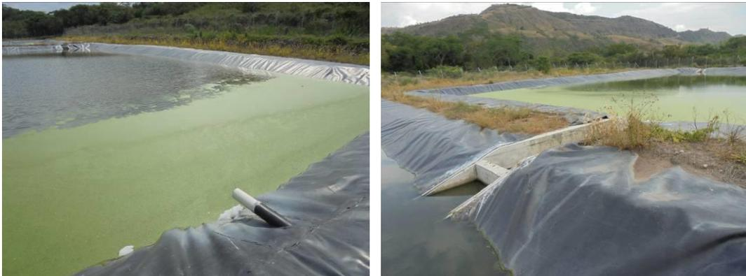
**ILUSTRACIÓN 20 ESTRUCTURA DE CONTROL A LA SALIDA DEL AGUA TRATADA DE LA ALGUNA DE MADURACIÓN QUE ENTREGA A LA ALCANTARILLA DE DESCOLE AL RIO MAGDALENA**
