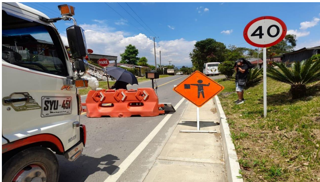
Figura 40. Señal de pare, costado 1. Kilómetro 2.
