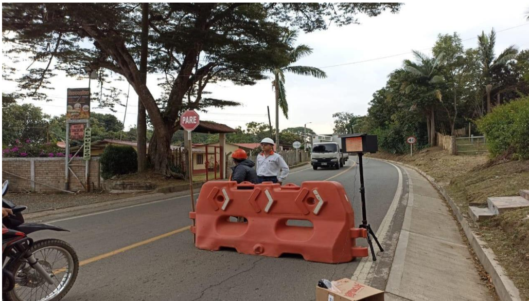
Figura 48. Señal de pare, costado 2. Kilómetro 12.
