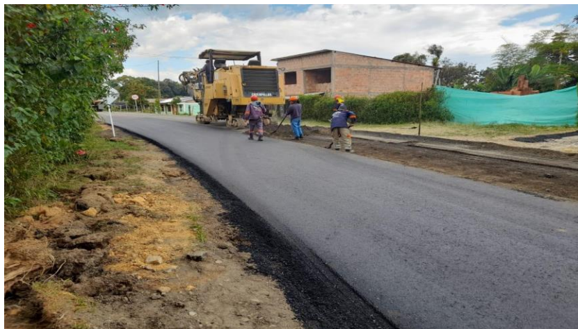
Figura 1 Mantenimiento y reparación de vías (elaboración propia).
