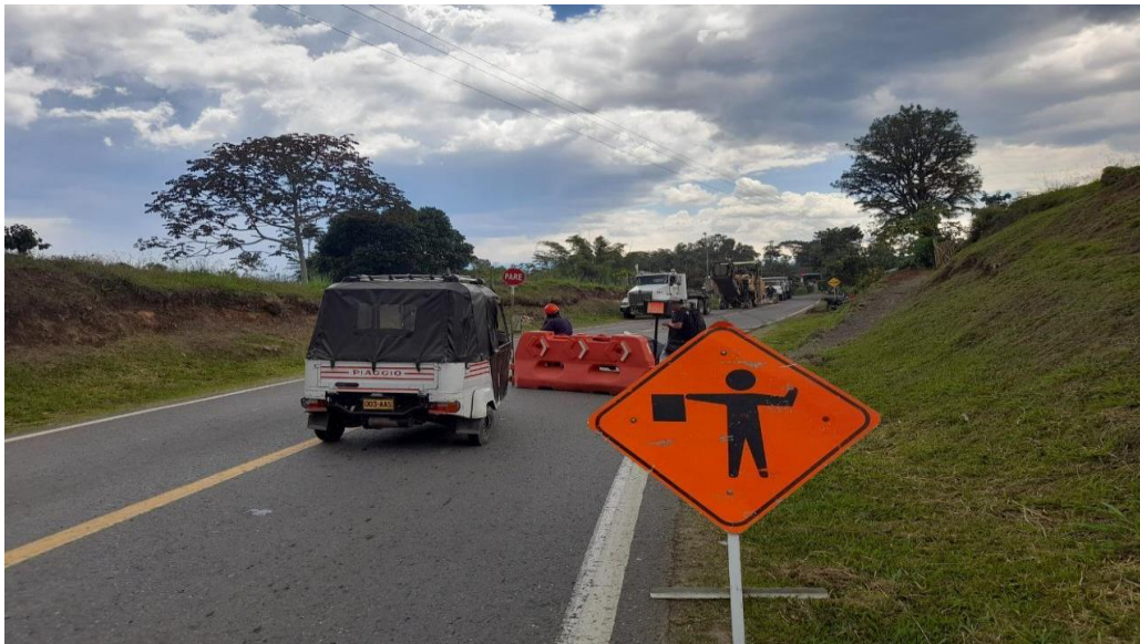
figura 42. Señal de pare, costado 2. Kilómetro 2.
