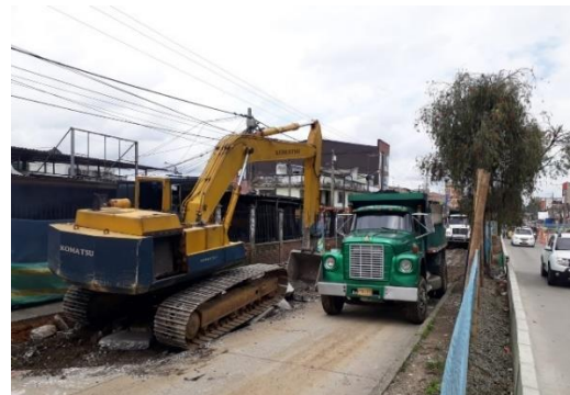
Fotos 13 y 14: Levantamiento de carpeta asfáltica tramo 7C
