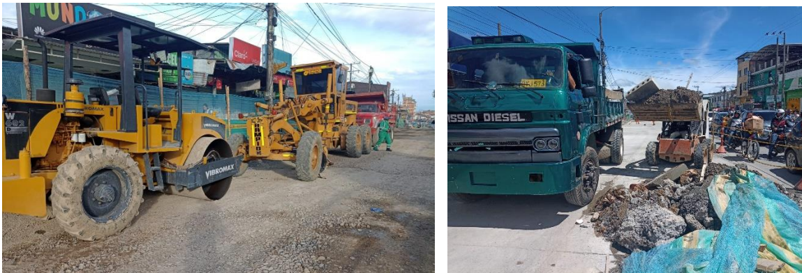
Fotos 23 y 24: Maquinaria pesada y vehículos de carga
