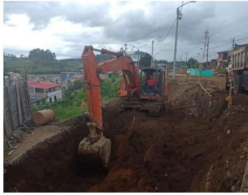
Fotos 11 y 12: Excavaciones para muros en el tramo 7B
