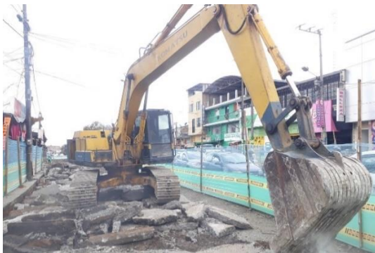
Fotos 13 y 14: Levantamiento de carpeta asfáltica tramo 7C
