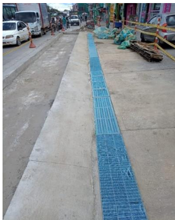
Fotografías 29 y 30: Protección de sumideros en la obra Tramo 7C
