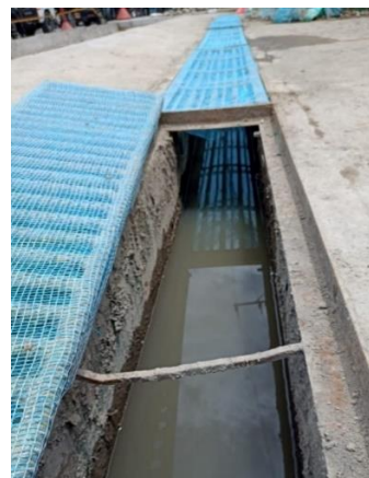
Fotografías 29 y 30: Protección de sumideros en la obra Tramo 7C
